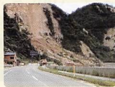
▲土砂崩れの様子
