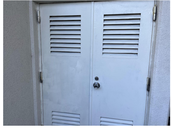
26日 ごみ倉庫ペンキ作業
