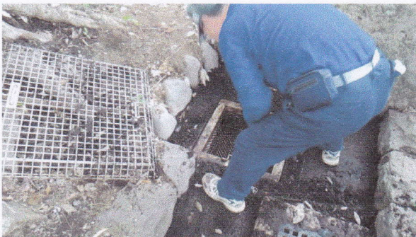
水路の出口です。泥が満杯でした
