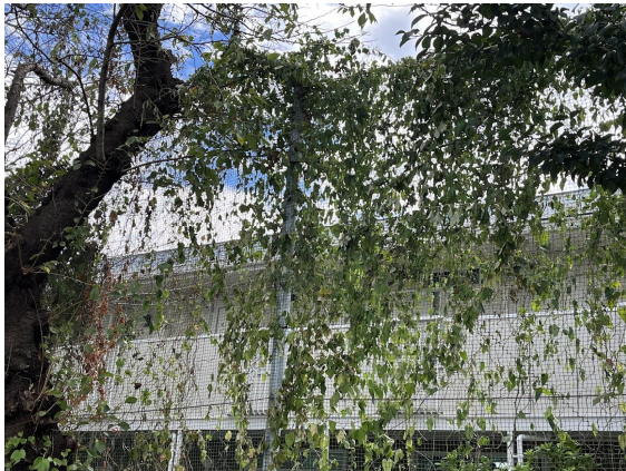
20日 ネットの吊り除去
