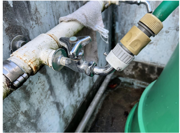
11日水もれ修理
