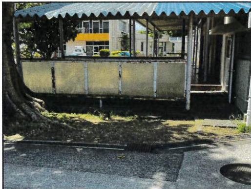
29日渡り廊下外側
