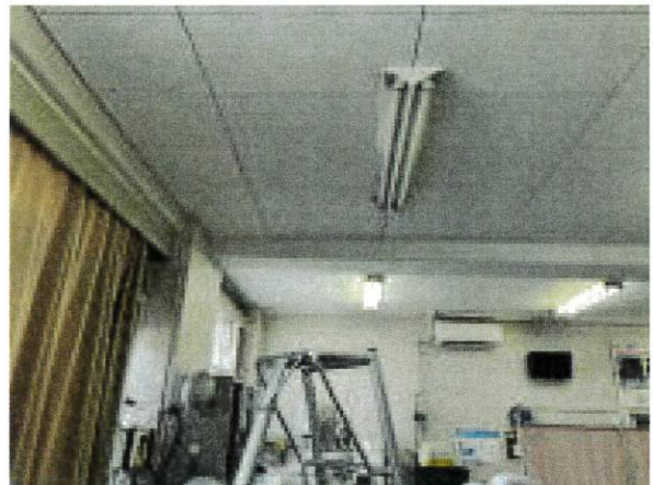
保健室蛍光灯交換
