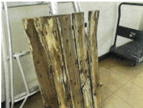
シャワーのすのこ破損
