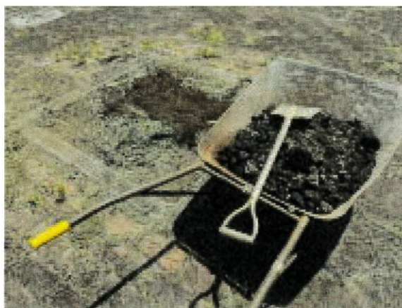
中庭の部分の土を盛りました。
