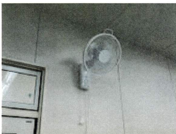
扇風機の取付
