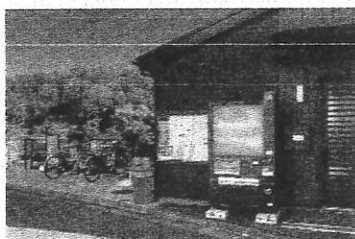
自治会町内会館への設置例
