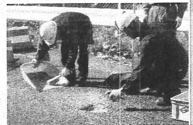
<道路の設備修繕>
