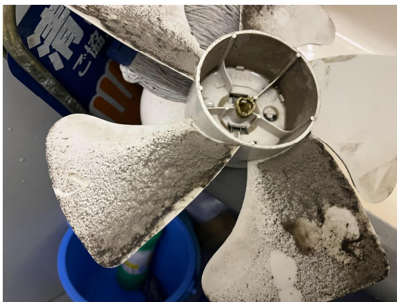
4日 トイレ換気扇清掃
