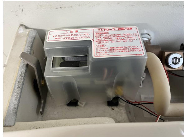
6日 小便器補修
