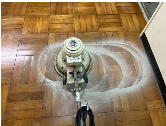
6日 トイレ前剥離作業
