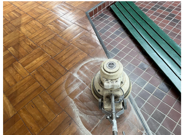
6日 玄関剥離作業
