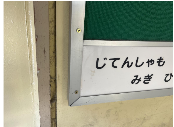
10日 掲示板修理
