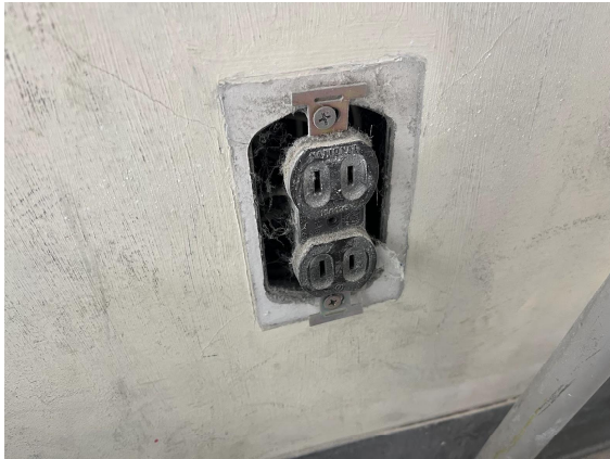
13日 廊下コンセント修理
