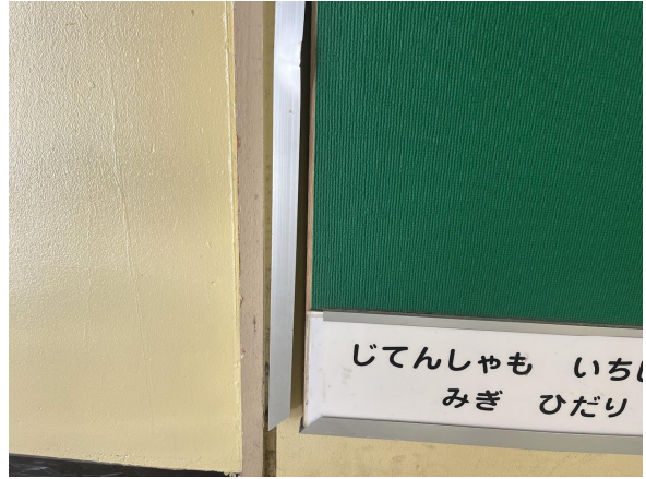
10日 掲示板修理
