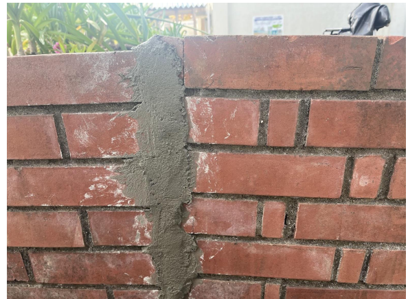
12日 セメントで仕上げ
