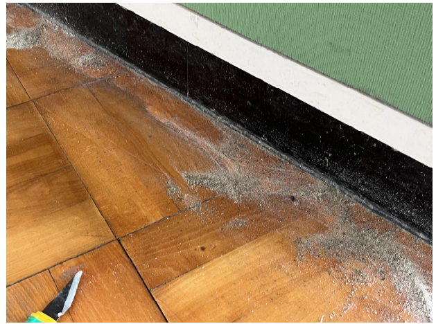
27日 細かいところの剥離作業
