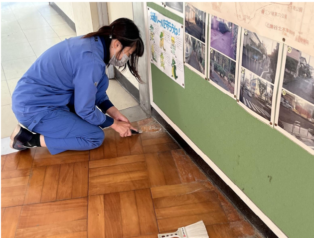
27日 細かいところの剥離作業
