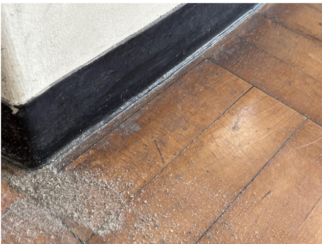
27日 細かいところの剥離作業
