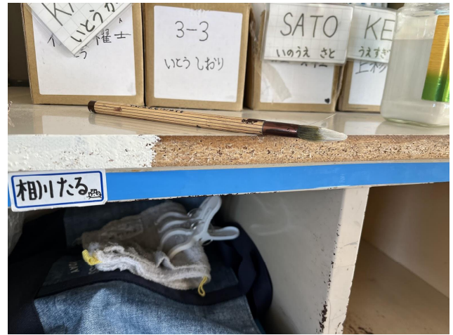
26日 5-3 教室ロッカー補修
