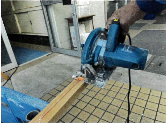
枠を軽量にするため、垂木を縦半分に切断。
