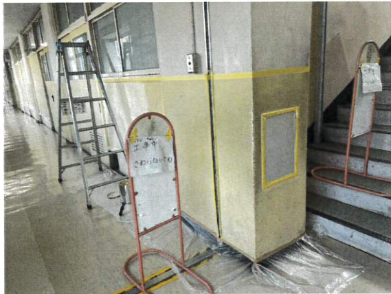
21日 階段かど、ペンキ作業
