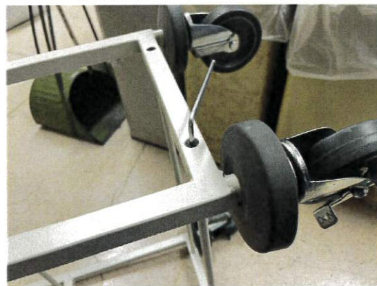
22日 図書室備品修理
