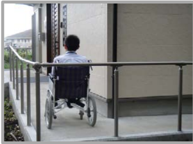
玄関前スロープ
