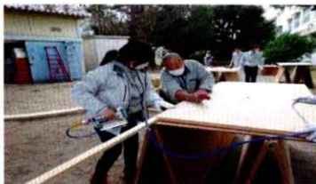
合板の張り付け
