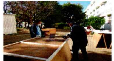
枠組みの組み付け
