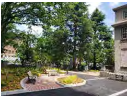
横浜開港資料館(中区)
