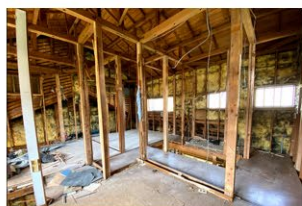
既存壁等解体
