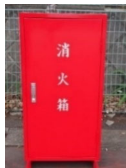
初期消火箱（固定式）
