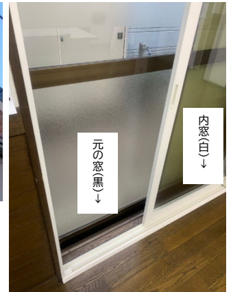
↑窓の断熱化（内窓の設置）
