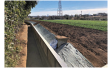
土砂流出防止対策/都筑区
