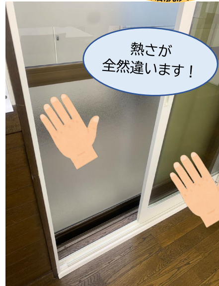
↑ 導入した断熱窓 (既存の窓に内窓を設置)
