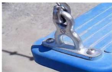
ブランコの吊り具一式(フック・チェーン・座板)が新規交換
