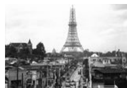
↑ 東京タワー建設
