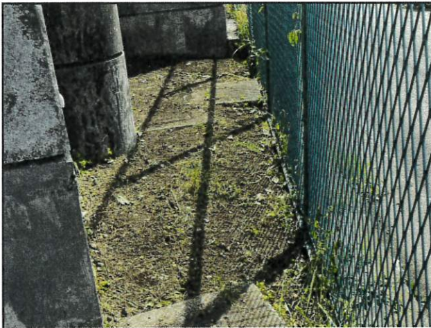
格技場横付近
