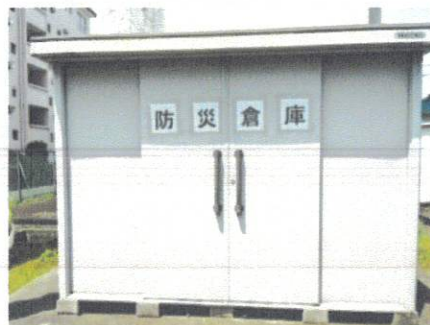
▲地域共用の防災倉庫
