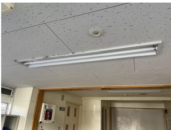
30日 体育館蛍光灯交換
